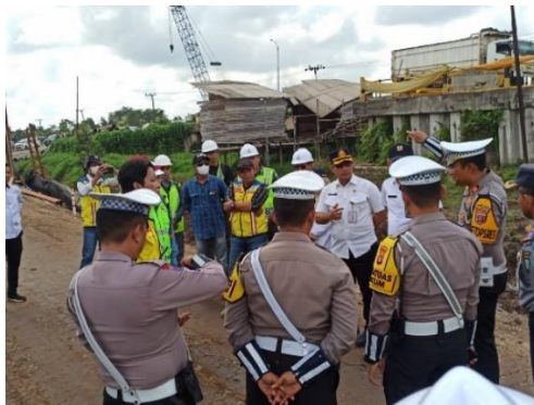
Pemantauan pembangunan jembatan Sei Lenggana KM 21 bersama Satlantas Polres Kotim
