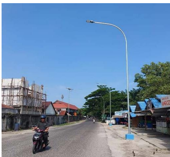
Gambar 3. 4 Tiang PJU yang baru terpasang di sepanjang Jl. Pemuda Tahun 2025
