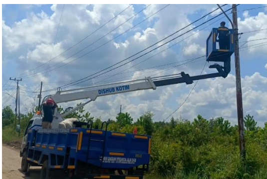
Proses Pemasangan/perbaikan PJU di beberapa kawasan kabupaten kotawaringin Timur
