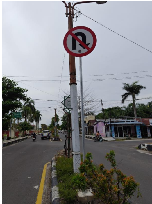
Gambar 3. 3 Rambu Larangan Putar Balik Simpang Tiga Jalan Ahmad Yani – Jalan Seribu Dahan yang baru terpasang Tahun 2025
